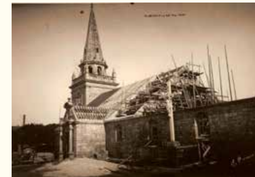
Eglise Saint-Pierre en 1947 en cours de réfection suite aux bombardements de 1943 Archives municipales de Plœmeur
